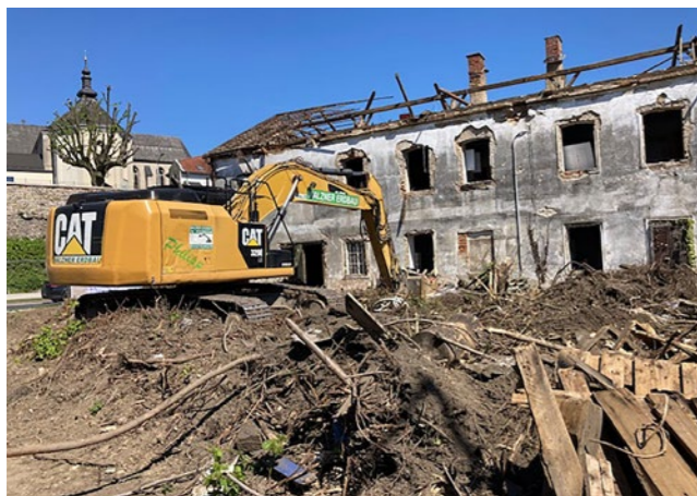
Alltäglich: Entsorgung historischer Architektur als „Kulturschutt“ Enns, im Nahbereich der Stadtpfarrkirche, 2025
