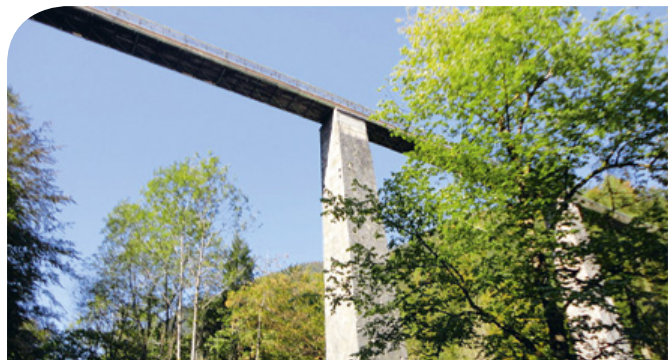
DIE SOLELEITUNG VOM HALLSTÄTTER SALZBERG ÜBER DIE ALTE SALINE IN BAD ISCHL ZUR NEUEN SALINE EBENSEE BESTEHT SEIT ÜBER 400 JAHREN, WAS SIE ZUR ÄLTESTEN PIPELINE DER WELT MACHT. DIE 30 METER HOHE BRÜCKE IM GOSAUZWANG STEUERT WESENTLICH ZUM FORTSCHRITT BEI.
