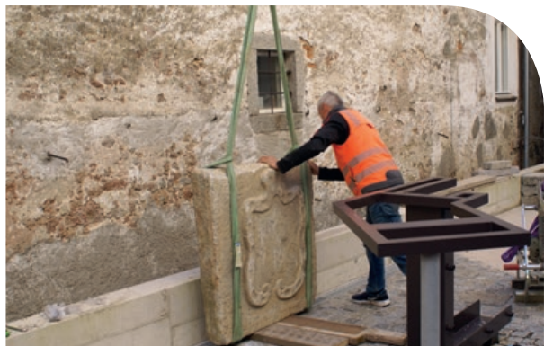
▼ ABB. 7: MONTAGE DES STEINS. | FOTOS: FRITZ WIMMER
