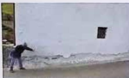
Abb. 9: Frostschäden im Sockelbereich
