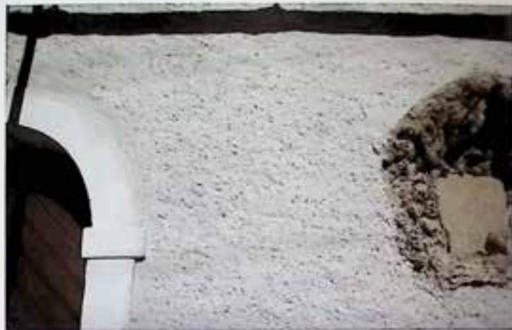
Abb. 8: mit Kalkschlämme gestrichene Oberfläche
