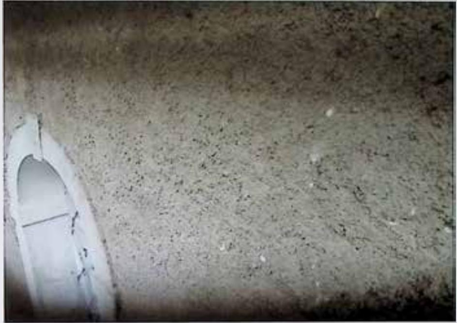
Abb. 4: In den Putz eingearbeitete Kalkspatzen
