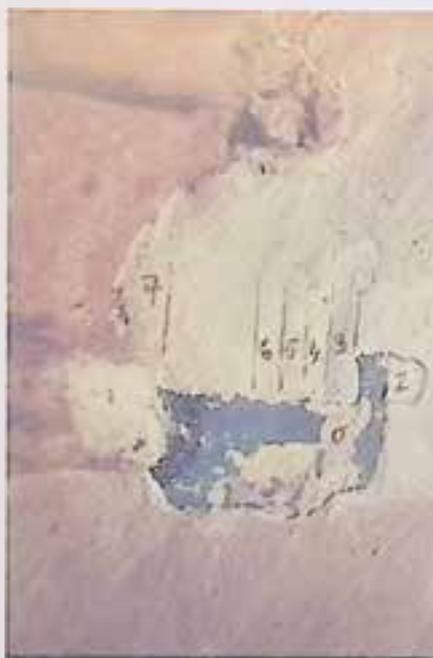
*Bäckerkapelle, Gewölberippenkonsole und Seitenwand hinter dem Bäckeraltar: Freilegungsproben zeigen ursprünglichen Blauanstrich der Seitenwand und schwarz konturierte hellgraue Rippen, darüber sechs hellbeige bis graue Überstriche bis 1954.*
