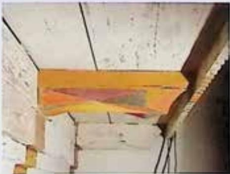
Bachmanning, Pfarrkirche, Detail der gotischen Holzempore mit Freilegungsprobe der gotischen Originalfarbigkeit. – Foto: J. Reiter.
