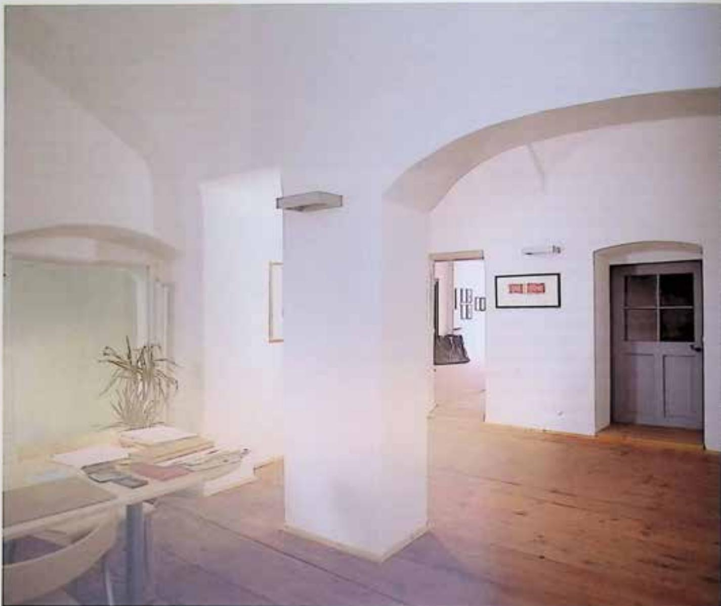
*Inneres im 2. Obergeschoss mit erhaltenen und sanierten Schiffböden. – Foto: BDA.*
