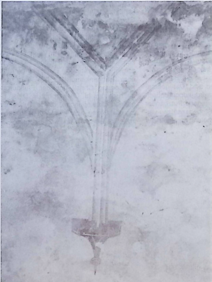
Abb. 9: Schlägl, Turmkapelle neben der Stiftskirche, Detail der scheinarchitektonischen Ausmalung mit Wandkonsole, Rippendreistrahl und Schildbögen. Zustand nach Entfernung der Vormauerungen 1990.
