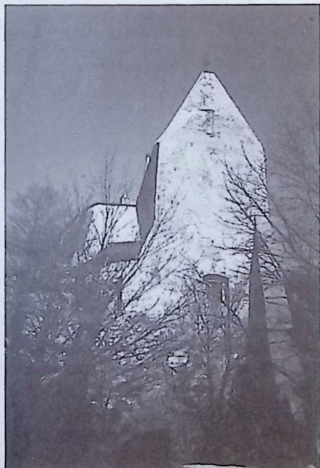
Abb. 4: Alt-Pernstein. Der steilaufragende Giebelsporn im Südwesten der Anlage. Die Mauerflächen haben z. T. noch den alten Putzauftrag. Es werden immer nur Ausbesserungen, nie Erneuerungen vorgenommen.
