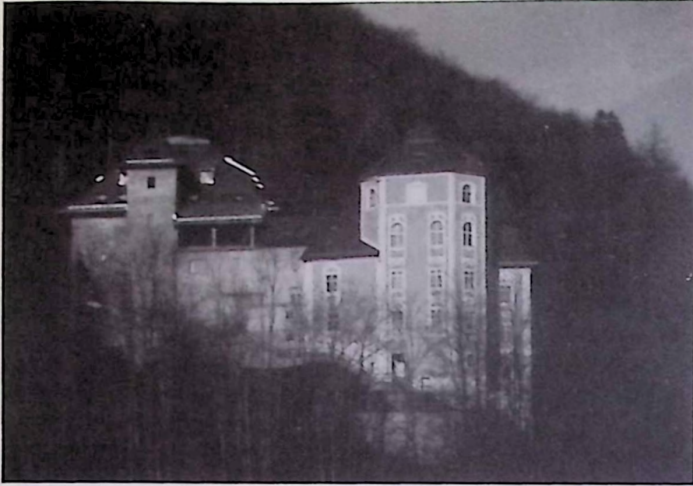
Abb. 6: Klaus. Südansicht. Zustand nach dem Ausbau. Die Aufmauerung des ehem. Torturmes ist deutlich zu erkennen. Der restliche Bestand verblieb in der überkommenen Höhe. Der Gesamteindruck konnte im wesentlichen gewahrt bleiben.
