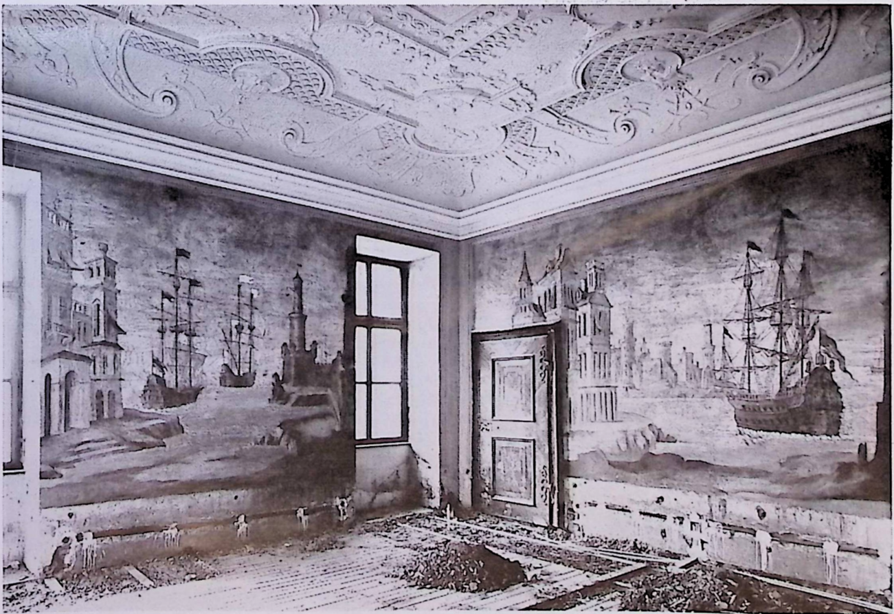
Hohenbrunn, Saal 3, mit reichem Deckenstuck und barocken Wandmalereien, Zustand während der Restaurierung, Fresken und Stuck bereits instandgesetzt.
