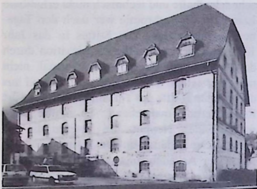
Weyer, Innerberger Stadel: Wirtschaftsgeschichtlich bedeutendes Objekt, durch neue Nutzungsforderungen insbesondere im Inneren gefährdet.
