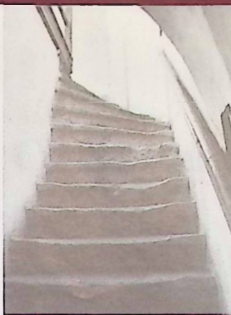
Altersästhetik und Geschichtszeugnis: Generationen haben sprechende Spuren auf den abgetretenen Konglomeratstufen hinterlassen
