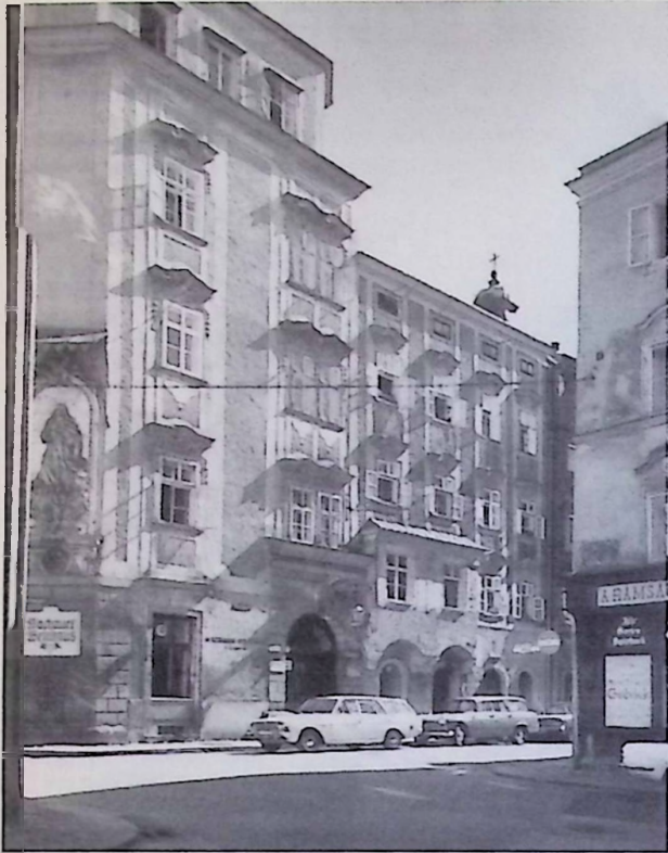
Linz, Altstadt – Das Streiflicht bringt es an den Tag: Unwiederholbare handwerkliche Lebendigkeit des Altputzes und harmonische Einfügung der fassadenbündigen, nach außen aufgehenden Holzkastenfenster
