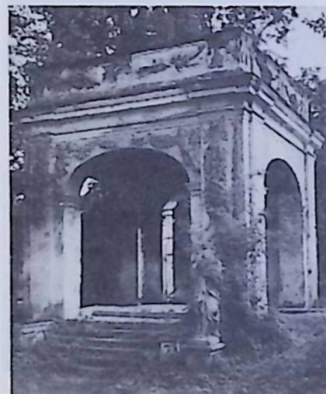
Wels, Schloß Lichtenegg: Barocker Gartenpavillon über dem Mühlbach, schwer gefährdet. Bedeutende Gartenarchitektur innerhalb einer stark verwilderten Parkgestaltung des 19. Jhdts.
