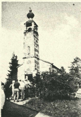
Kapelle aus Bloßsteinmauerwerk in Wienau/Mühlviertel
