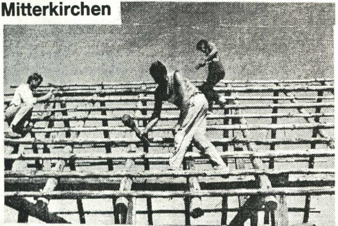
Mehr als 300 Holznägel sind allein für die Dachkonstruktion am Getreidespeicher nötig.
