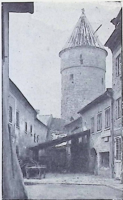
Scheiblingturm in Freistadt (Eindeckungsarbeiten)
